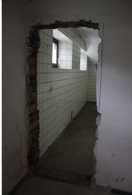
Hier die analoge Situation des zweiten Referenzimmers, von dem aus die Perspektive in das zugehörige Bad geht. Das Zimmer bestand bereits, nur der Türdurchbruch zum Bad, das etwa so breit werden wird wie das erste Fenster, wurde neu geschlagen.
