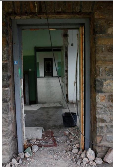
Hier der Durchgang vom Café in den Treppenraum und dahinter in den Ausstellungsraum. Der Türrahmen im Café wird gerade abgebrochen, auch da entsteht Schutt. Der Treppenraum ist mit Matten ausgelegt, damit die rotbraune Verklammerung geschont wird, die denkmalgeschützt ist und erhalten werden muss.
