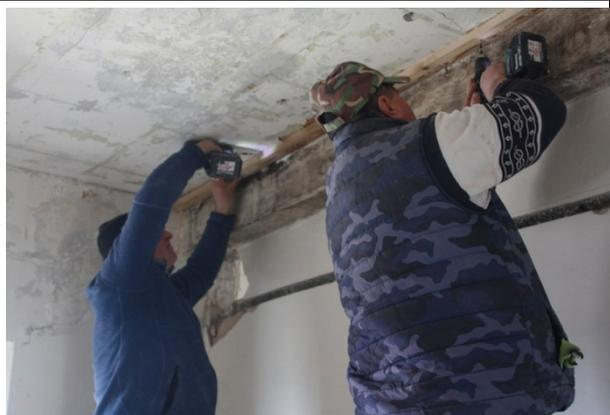
Hier werden Latten zur Befestigung von Rigipsplatten an den Decken der Gästezimmer angeschraubt...
