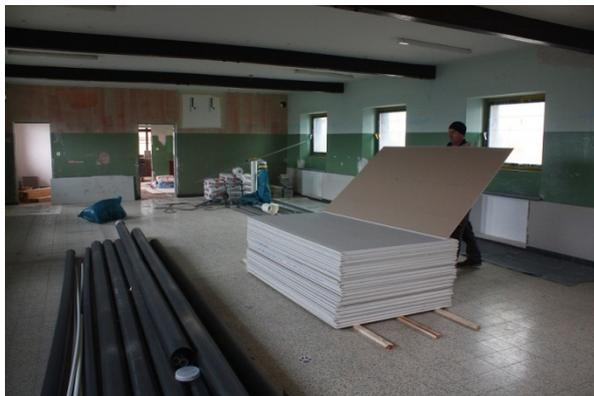
Viel Material, insbesondere auch für die neue Heizung ist angeliefert worden. In unserem zukünftigen Ausstellungsraum stapeln sich neben Rigipsplatten auch diese langen, grauen Verpackungshülsen, in denen sich zum einen Kunststoffrohre für Wasserleitungen und zum anderen Kupferrohre für die Heizungsleitungen befinden.
