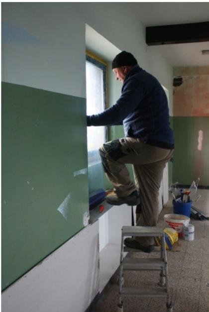
... unser rumänischer Mitarbeiter Wassili beim Abkleben der Fenster im Ausstellungsraum. Hier wird mit der Grundierung der Wände weitergemacht – und die darf nicht auf die Fensterrahmen gelangen.
