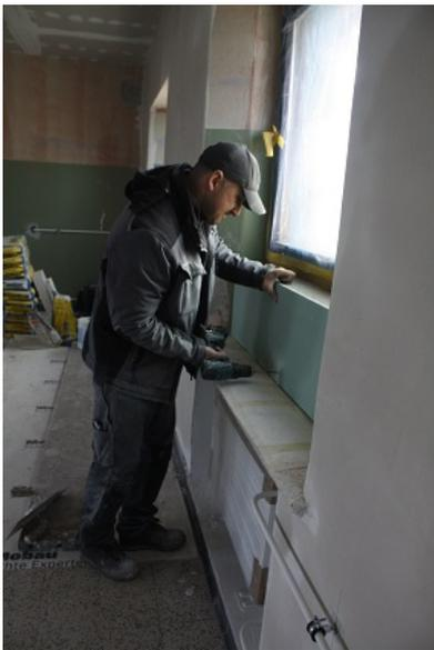
Zunächst werden die Fenstergewände hergerichtet. Vorbereitend werden für die Wand unter der Fensterbank Gipskartonplatten zugeschnitten und angeschraubt.
