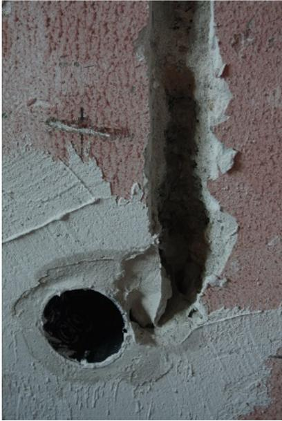
Der nächste Schritt sieht dann so aus: Der Putz ist zwischen den beiden Schlitzen herausgeklopft worden, eine Dose wurde in das Loch gesetzt und eingeputzt. Jetzt fehlt nur noch die Litze.
