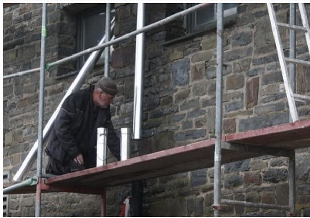
Es folgen nun noch Ergänzungsarbeiten. Hier werden die Abflussrohre der Dachrinne an der Nordseite gesetzt, die das Regenwasser in unsere Regenwassertanks leiten. Auch werden an alle Dachflanken noch Leiterhaken gesetzt.
