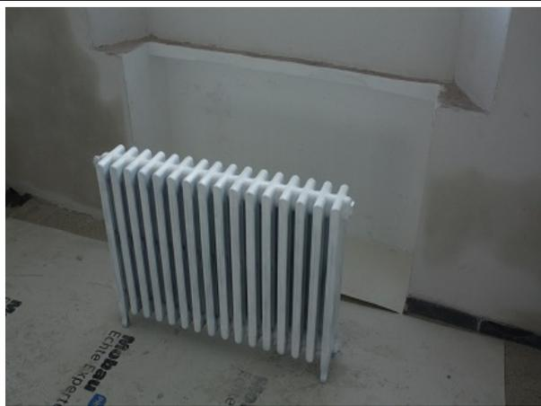
Am nächsten Tag werden die Heizkörper auf die sechs Gästezimmer der oberen Etage verteilt. Hier stehen die komplett sanierten Heiznischen für die Aufnahme bereit. Es fehlt noch der Anschluss an die Heizleitungen.
