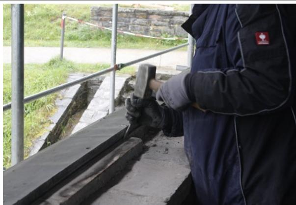
Anschließend wird der alte Putzsockel mit einem Meißel und ein paar Hammerschlägen entfernt. Nun kann der neue Rahmen an dieser Stelle eingepasst werden. Er wird auf Bolzen gesetzt, die justierbar sind.
