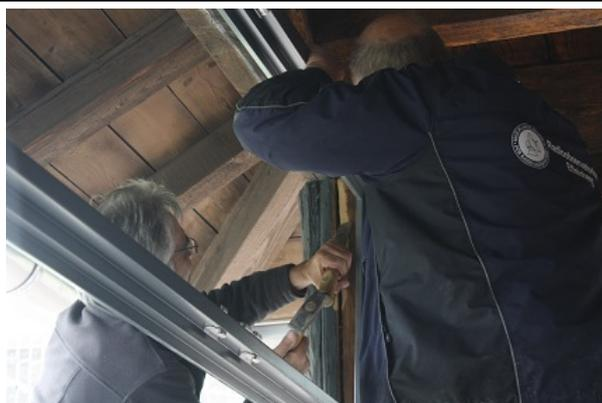
.... und der erste Fensterrahmen wird zunächst ausgebaut und dann durch den neuen ersetzt. Dieser große Leerrahmen wird in Handarbeit präzise eingepasst und befestigt. Hier wird gerade vorsichtig eine dünne Holzschicht von einem der Pfosten abgestemmt, die den Rahmen halten sollten.
