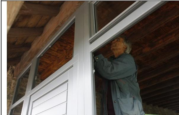
Hier ist die neue Tür bereits eingesetzt und das darüberliegende Fenster wird gerade montiert. Am Mittwochabend ist die Südfront unserer Ostkanzel zwar noch nicht fertig, aber geschlossen.
