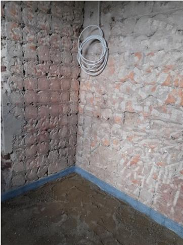
Auch in dem benachbarten Schlafraum des Referentenzimmers wurde der Boden aufgefüllt. Später kommt noch eine Schicht Estrich auf den Sand.
