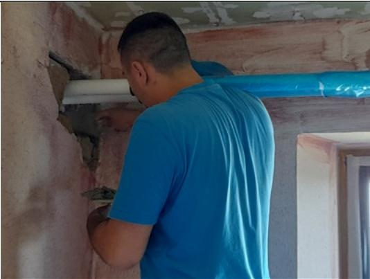
Hier werden in einem der Gästezimmer der unteren Etage die Wandlöcher für die Heizungsrohre geschlossen.
