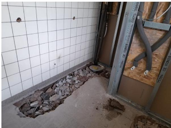
.... Gräben und Löcher verfüllt. Das spart Entsorgungs- und Neubeschaffungskosten. In diesem zukünftigen Duschaum für die Übernachtungsgäste ist er Duschabfluss im Boden bereits als grauer Teller mit gelbem Verschluss zu sehen. Der umgebende Abflussgraben, in dem die Abwasserrohre liegen, wurde mit Abraum verfüllt.
