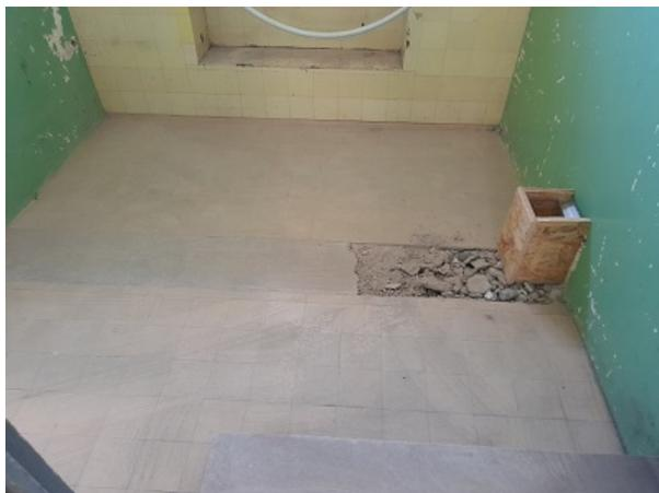
Es gibt in unserem Haus einige Räume, in denen der Boden tiefer liegt als in anderen. In diesen zukünftigen Lagerraum z.B. geht man über zwei Treppenstufen. Deshalb wird hier der Boden angehoben, was durch Auffüllen erfolgt.
