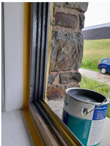
... bevor der erste Probeanstrich an einer versteckten Innenseite eines Rahmens erfolgt: ist dieses Grau dasselbe wie das der Fensterrahmen in den Kanzeln? Diese Frage muss Schreinermeister Böttcher beantworten.
