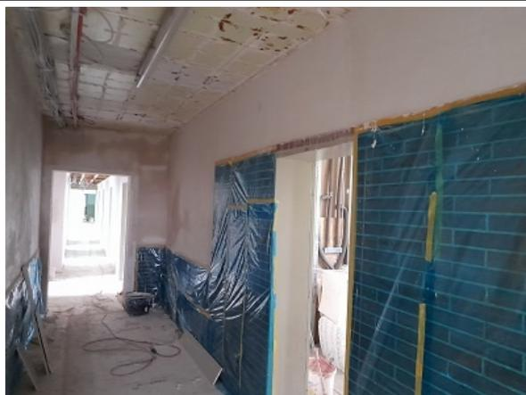
... die dann Mitte der Woche ebenfalls verputzt ist. Rechts ist die Wand schon weitgehend abgetrocknet, hinten trocknet sie gerade. Die noch fehlende Tür gewährt einen Blick in den dahinterliegenden Flurabschnitt mit den Gästezimmern, in dem der bereits getrocknete Putz hell erstrahlt.
