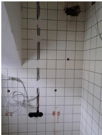
Rechts daneben die Wandschlitzungen für die Stromversorgung von Waschmaschine und Trockner.
