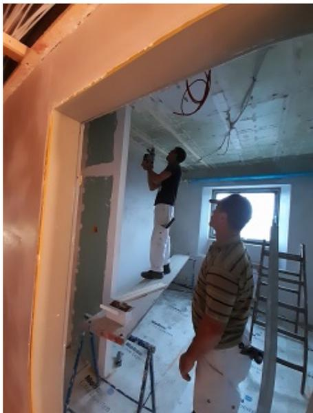
Im nächsten Schritt werden die Decken bearbeitet, von denen ja schon im Winter die Styroporplatten entfernt worden waren und die jetzt auch mit Stromleitungen versorgt sind. Diese entkleideten Decken werden nun mit Latten bestückt...
