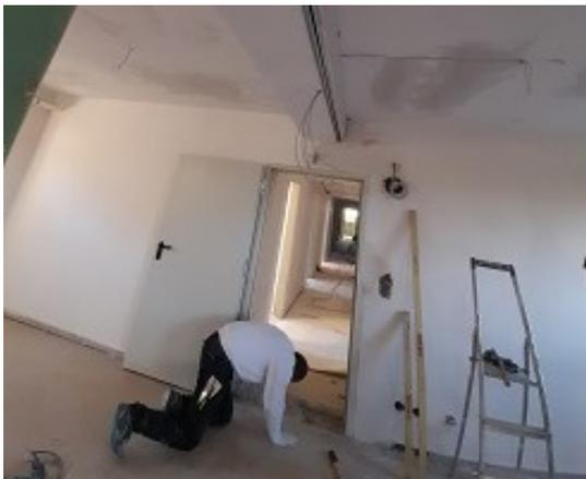
Im Seminarraum wurde gerade die erste Türzarge mit Feuerschutztür eingesetzt.
