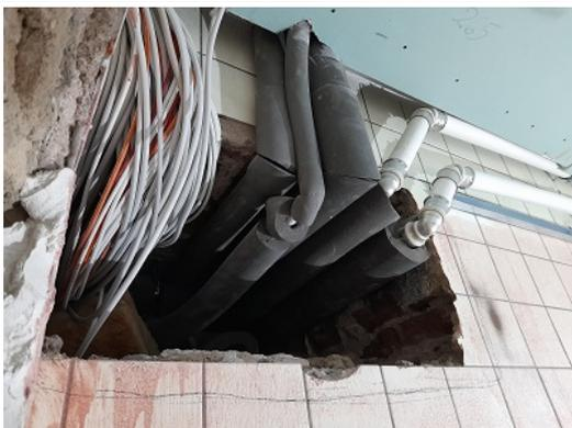
So sieht ein Wanddurchbruch mit Wasser- und Heizungsleitungen sowie Stromleitungen ohne Abkofferung aus....
