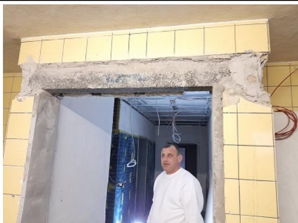
Für einige der Feuerschutztüren müssen die Türstürze neu gesetzt werden, wie zum Beispiel hier im Toilettenraum unter der Westkanzel.
