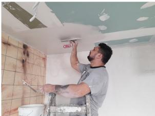
Die obere Raumhälfte muss also noch fertig saniert werden. Dazu wird zunächst die Decke gespachtelt. Dann wird Spachtelmasse auch auf die Fliesen aufgetragen. Solange diese trocknet, ist die Struktur der alten Fliesen als Trocknungsmuster noch erkennbar. Sie verschwindet aber nach dem Trocknen spurlos.
