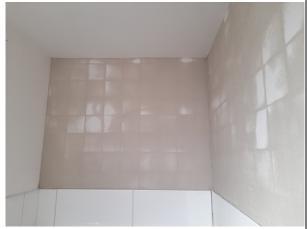
... und mit Spachtelmasse überzogen, wie auch die Decke. Hier trocknen die Wände gerade.
