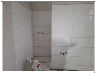
Das sieht schon aus wie ein heller, schöner Duschraum. Links die Anschlüsse für die Dusche, rechts für das Waschbecken. Diese beiden Sanitäranlagen werden später in einer Duschkabine zusammengefasst werden.
