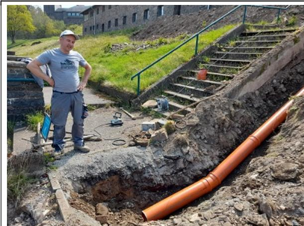
letzten Woche geschehen. Ein Test zeigte, das eingeleitetes Wasser am unteren Ende des Hangs nicht ankam. Dann also: Kamerabefahrung. Ergebnis: die Leitung ist mit Schutt verfüllt. Also musste unter Abstimmung mit den beiden Eigentümern der Häuser unterhalb von unserem eine neue Abwasserleitung verlegt werden. Das ging dann nicht ‚mal eben‘.
