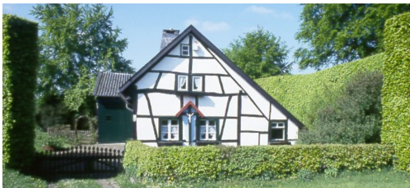
Von Hochhecken gerahmt: ein Vennhaus, ein traditionelles Fachwerkhaus mit einseitig tief gezogenem Dach im Monschauer Heckenland
